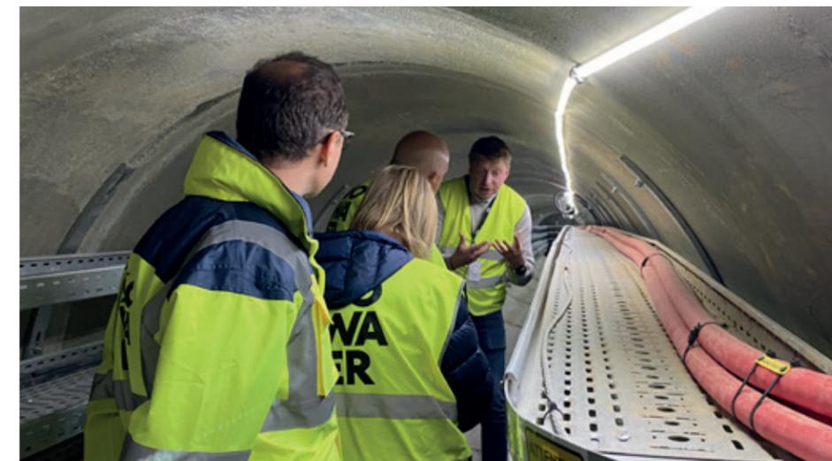
D'autre part, une rénovation des installations de balisage du taxiway alpha s'est avérée également nécessaire. Les travaux à réaliser consistent principalement au renouvellement global des circuits d'alimentation des installations de
