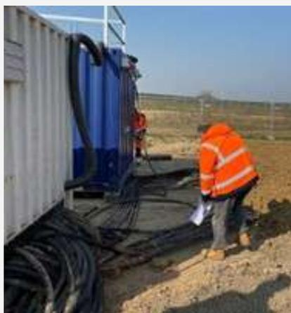
Les lances d'injection envoient de l'air sous pression dans le sol (venting) et dans l'eau souterraine (sparging). Cet air modifie l'équilibre chimique du sol et de l'eau et se « charge » en polluant.
